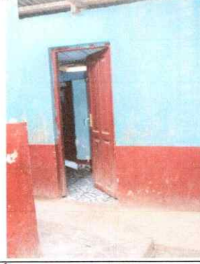
Foto 2: SUSTITUCIÓN DE PUERTA DE MADERA POR METAL POR DETERIORO.
