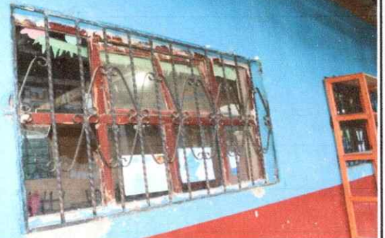
Foto 4: SUSTITUCIÓN DE VENTANAS POR DETERIORO.
